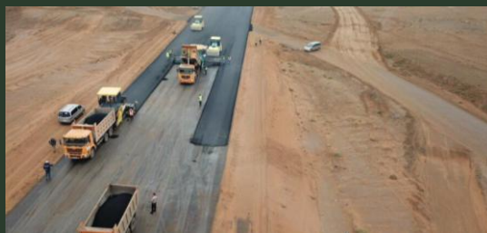
12. Актобе-Астрахань Реконструкция автомобильной дороги Актобе-Астрахань.
