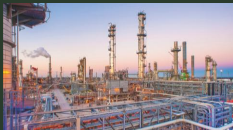
1. АНПЗ - КПА Строительство комплекса по производству ароматических углеводородов.
