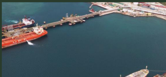
11. КТК Каспийский трубопроводный консорциум.
