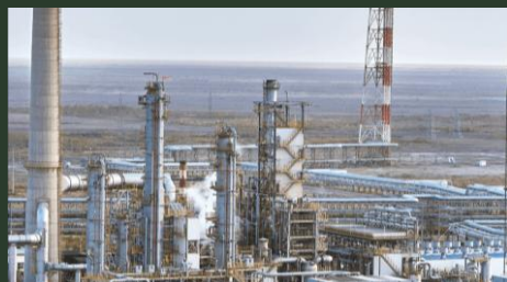
2. АНПЗ - КГПН Строительство комплекса глубокой переработки нефти.
